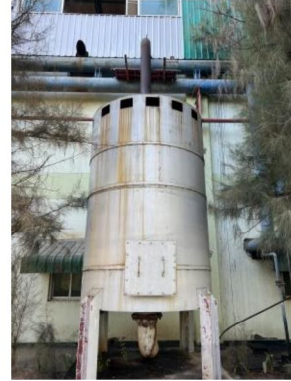
รูปที่ 19 การปิดครอบเครื่องจักรที่มีเสียงดัง
